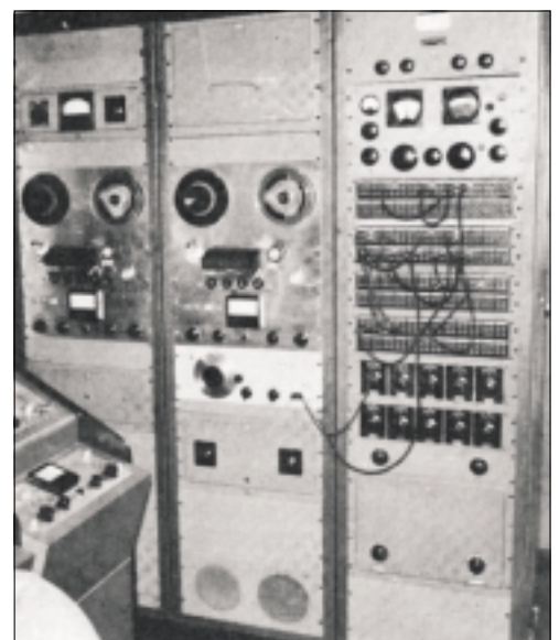
Die von Radio Swan benutzte Monitor- und Aufnahmeausrüstung. Zu sehen sind Ampex-Bandgeräte, Hammarlund Super Pro Empfänger sowie das Patchboard. Seinerzeit mit die beste und teuerste Ausrüstung die auf dem Markt war. Foto: CIA Pressefoto (1961).
