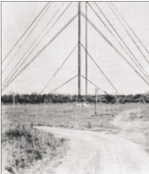
Blick von Südosten auf die Mittelwellenantenne von Radio Swan mit hurrikantauglicher Abspannung. Unter dem vorderen Mast ist das Häuschen mit der Abstimmereinheit zu erkennen. Quelle: CIA Pressefoto (1961).
