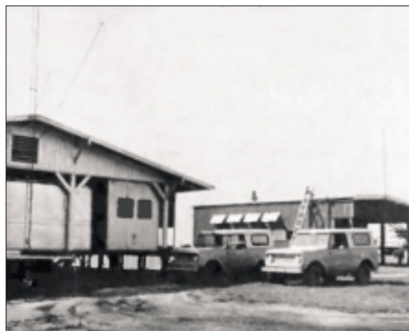
Links die Sendeanhänger unter einem Schutzdach, davor zwei Harvester Scout Geländewagen. Im Gebäude dahinter befinden sich zwei Dieselgeneratoren (1968). Quelle: Tom Kneitel.
