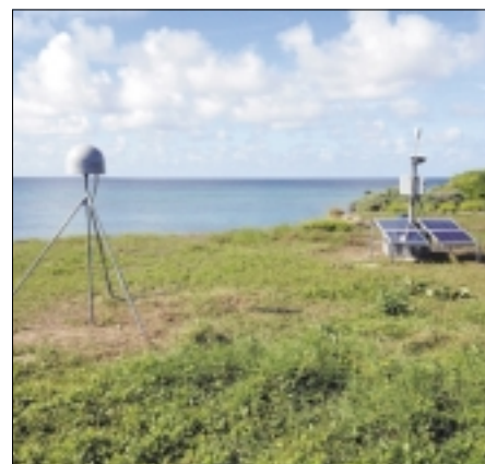
UNAVCO GPS-Messstation auf Swan Island. Foto: Michael Fend, UNAVCO.
