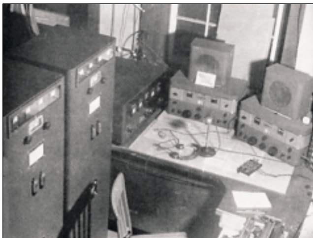
Funkstation des US-Wetterbüros auf Swan Island. Die zwei hohen Schränke links beherbergen die CW-Sender der Marine, in der Ecke daneben der 100 Watt Sender für das 14 MHz Band (HT9). Auf dem Tisch zwei AR-77 Empfänger sowie Kopfhörer, Mikrofon und Morsetaste (1940). Foto: Steve Paull.
