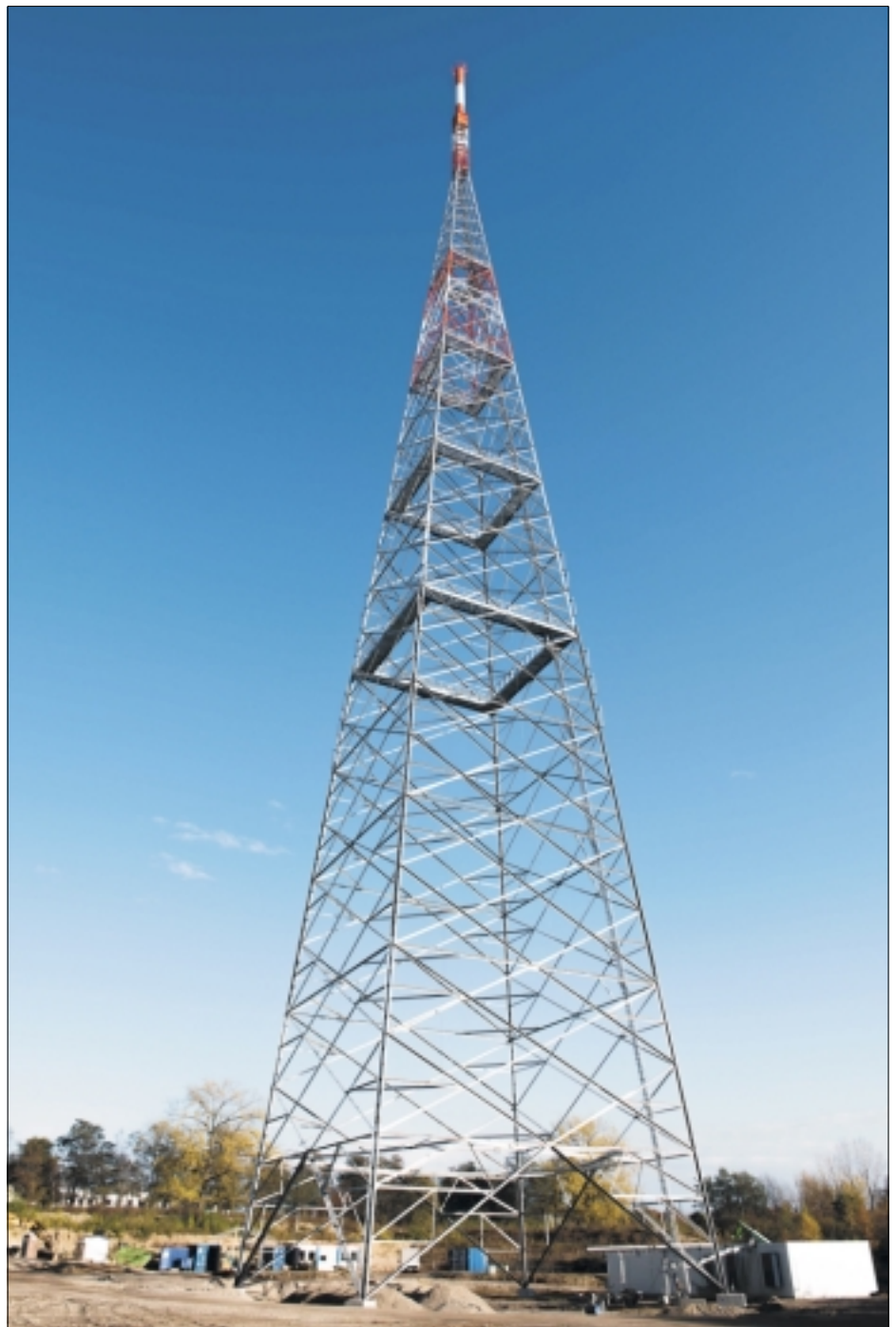
Funkturm der Sendestelle „Messegrund“ in Leipzig während der Bauphase; November 2015.
