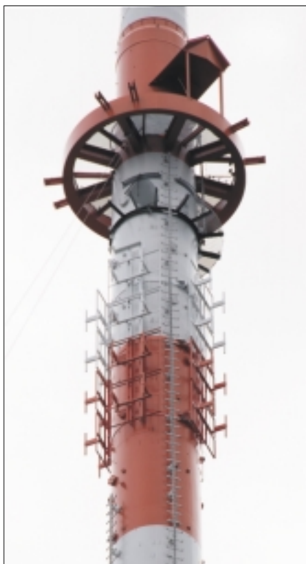
Dipolgruppe für DAB+ am Antennenturm auf dem Großen Inselsberg, Kanäle 5C und 8B, Inbetriebnahme Dezember 2015.
