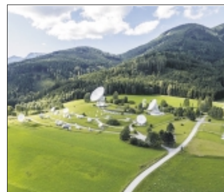
Gesamtansicht der Anlage.
