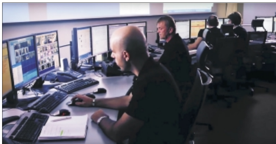
Blick in den Kontrollraum.
