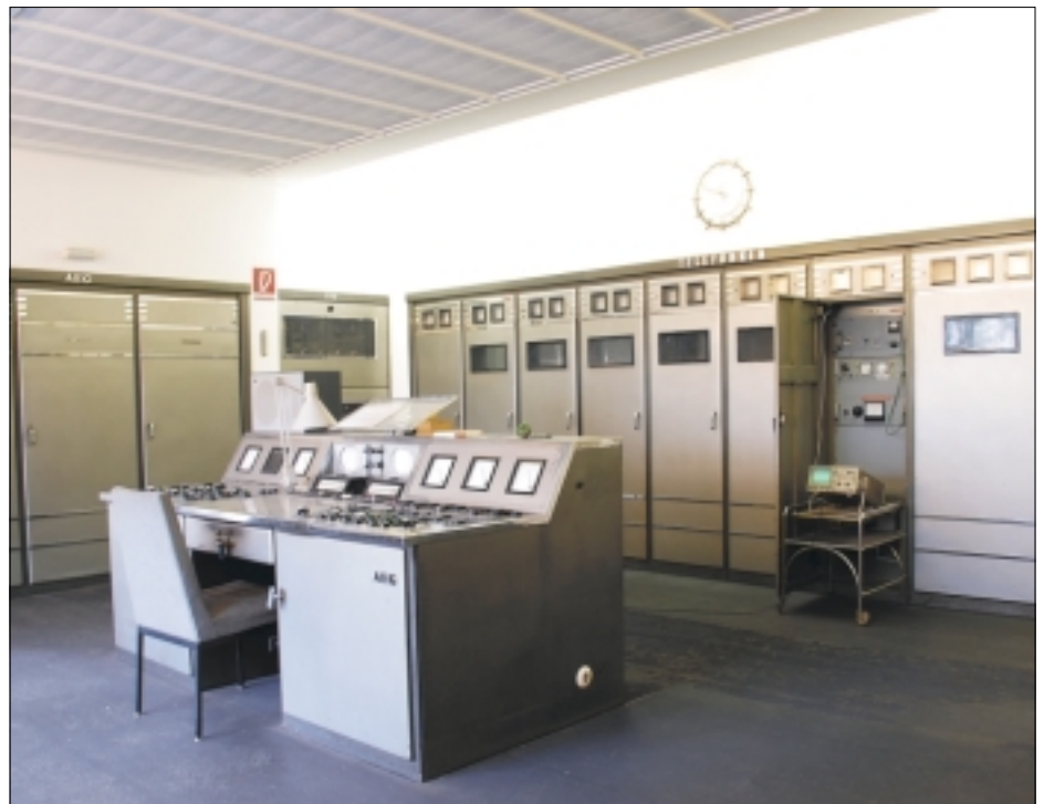
20-kW-Kurzwellensender von Telefunken in Berlin-Britz, Baujahr 1951, Foto aus dem Jahr 2008.
