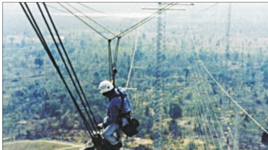
Wartungsarbeiten an den Antennen der Sendestation Udon Thani. Foto: VoA.
