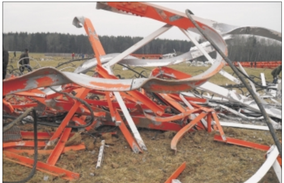
Trümmerfeld nach der Sprengung.
