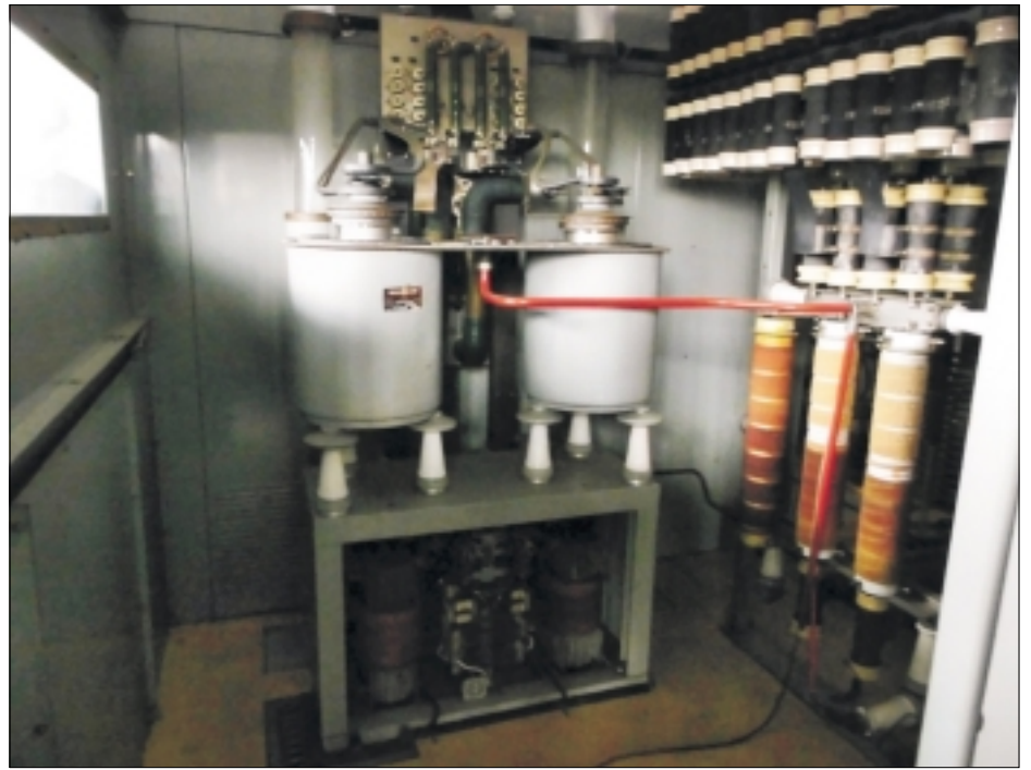
Die Antennenanpassung.
