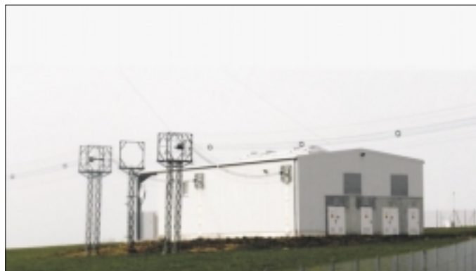
Aufgetrennte und in das neue Sendergebäude eingeführte Reusenleitung; links zur jetzigen Betriebsantenne, rechts von der bisherigen Sanderanlage. Foto: Jakob Roschy.
