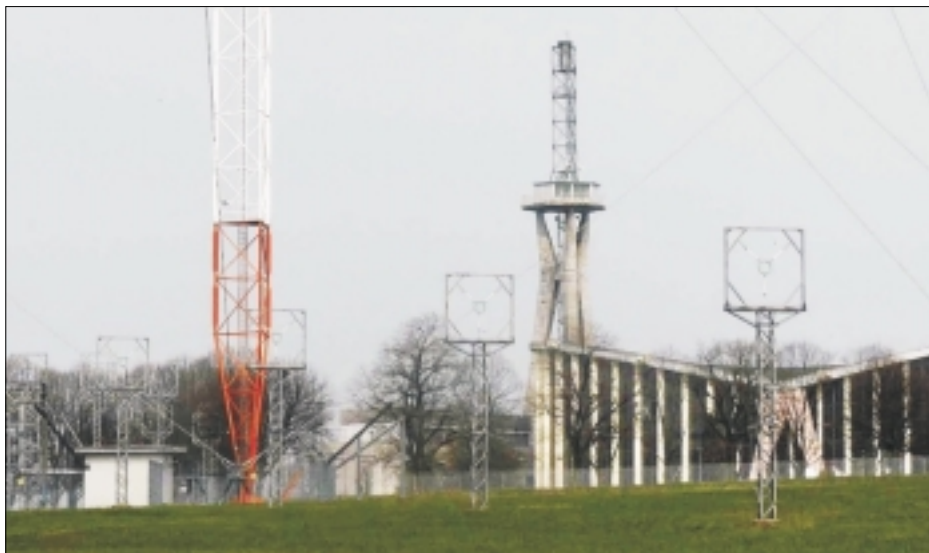
Von links nach rechts: Jetzt als Notantenne angeschlossener Mast, Anbau der früheren Antenneneinspeisung, einstiger Antennenträger von Telesaar, altes Sendergebäude. Foto: Jakob Roschy.
