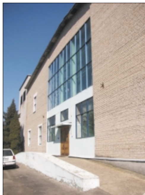
Das Technikgebäude der Sendestation Sosnowy.
