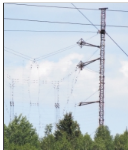
Detail einer Vorhangantenne der Sendeanlage Minsk-Kolodistschi. Foto: Wikimapia.
