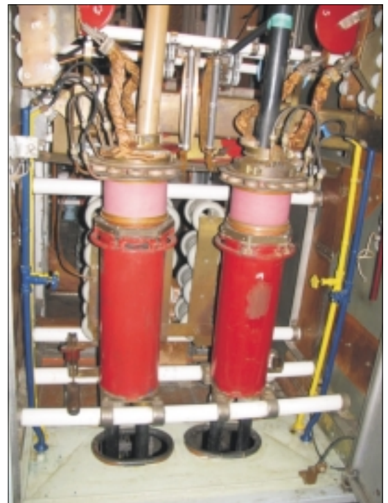
Senderröhren des Typs GU-88A in Sosnowy. Foto: leryfrm.
