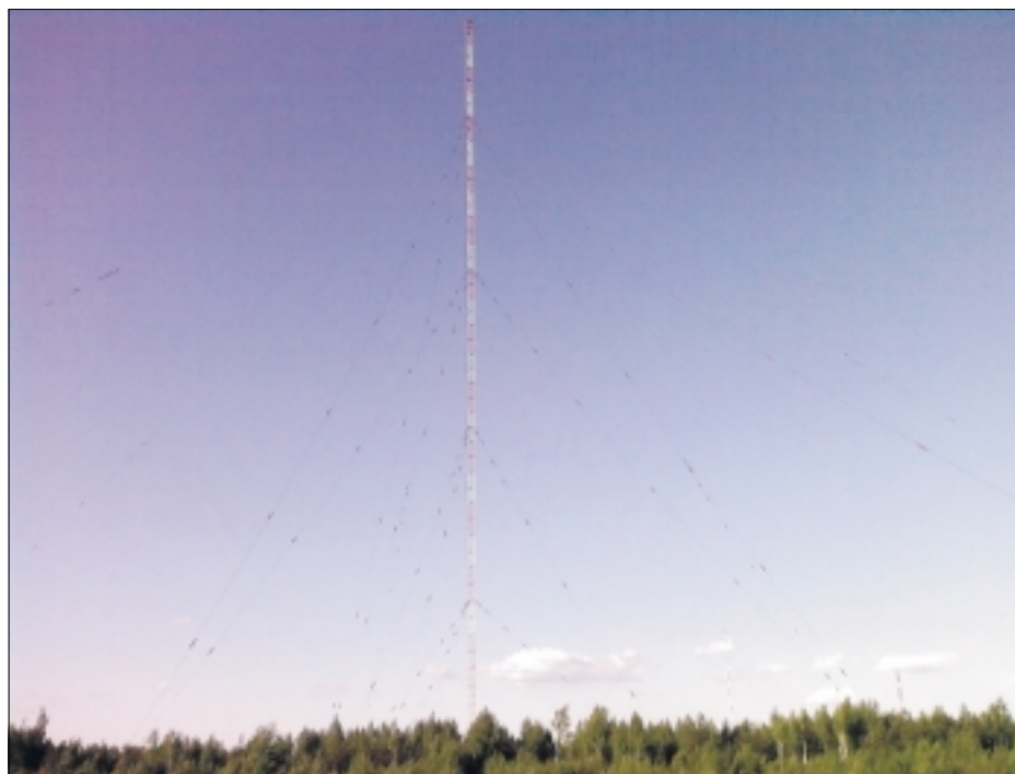
Der 353 Meter hohe Langwellenmast in Sosnowy. Foto: vcfm.ru.
