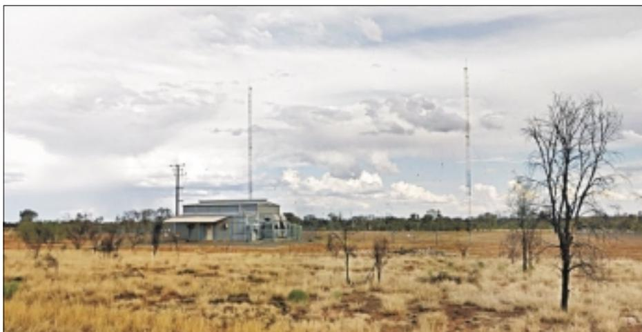
*Ansicht des Kurzwellensenders bei Alice Springs im Streetview-Dienst von Google. Hier nur zu erahnen ist die logarithmisch-periodische, zwischen den beiden Masten aufgespannte Antenne.*
