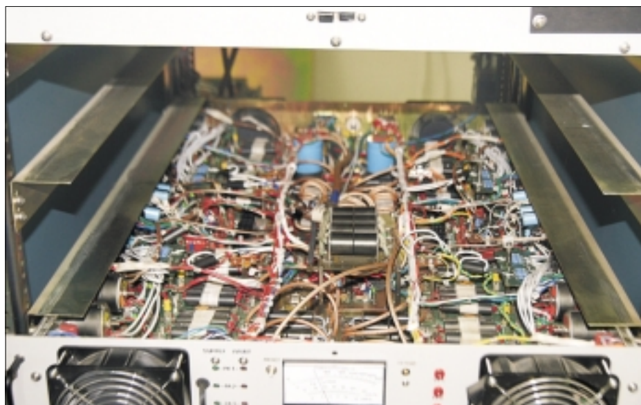
Mit diesem einzelnen Verstärkermodul ist die Kurzwelle 3290 kHz in Guyana am 2. Februar 2015 zunächst mit 400 Watt wieder in Betrieb gegangen.
