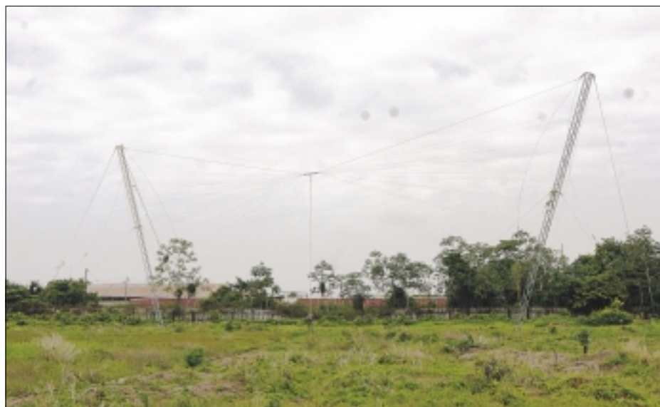
Die Kurzwellenantenne des National Communications Network von Guyana in Georgetown.
