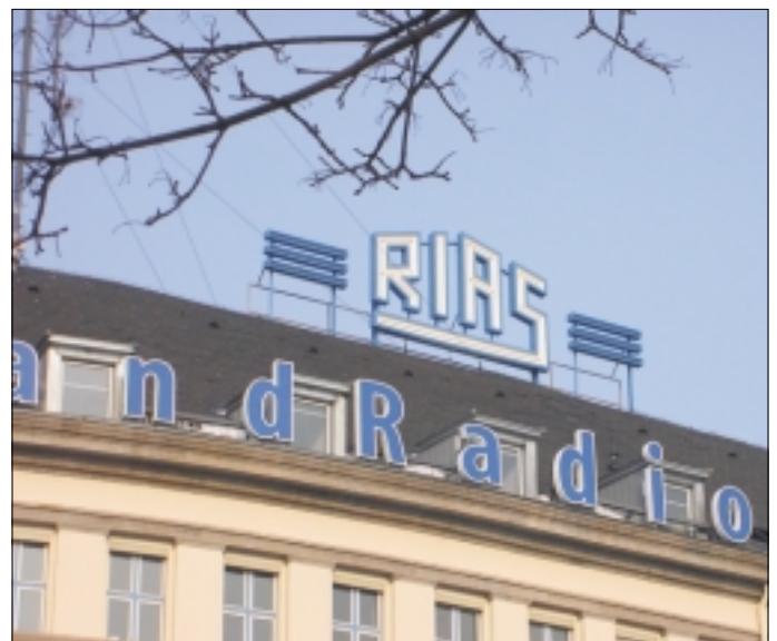
Alter RIAS -Schriftzug auf dem Funkhaus von DLR Berlin . Foto: Kai Ludwig.
