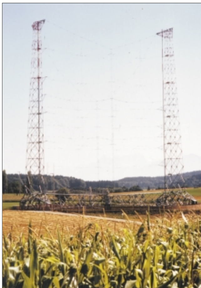
Die 2004 stillgelegte und kurz danach abgerissene Kurzwellenantenne in Sottens. Archivfoto von Schweizer Radio International.
