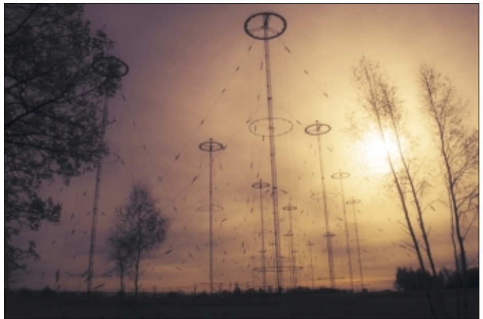
Mittelwellen-Richtantennen „SW 4+4“ der Sendestation Bolschakowo (2014). Foto:RTRS.
