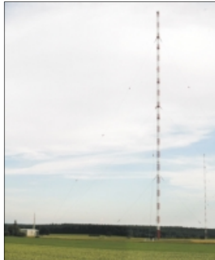
„Bodenseesender“ Meßkirch-Rohrdorf; v.l.n.r. Sendergebäude, Hauptantenne 240/244 Meter, Reserveantenne 138 Meter. Foto: Anonym via Wikipedia.
