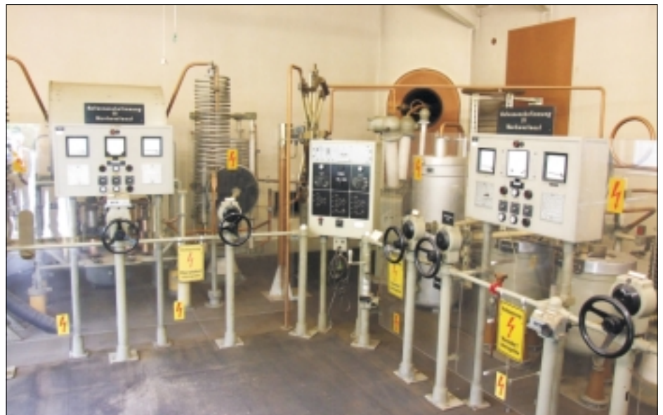
Mittelwellen-Abstimmittel des Nordwest-Mastes der Sendestation Berlin-Britz.
