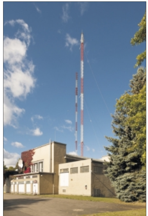
Noch mit beiden Masten: Die Sendestation Berlin-Britz; im Vordergrund das Hauptgebäude mit dem Anbau, den es für die von 1978 bis 1983 installierten Sender erhielt.
