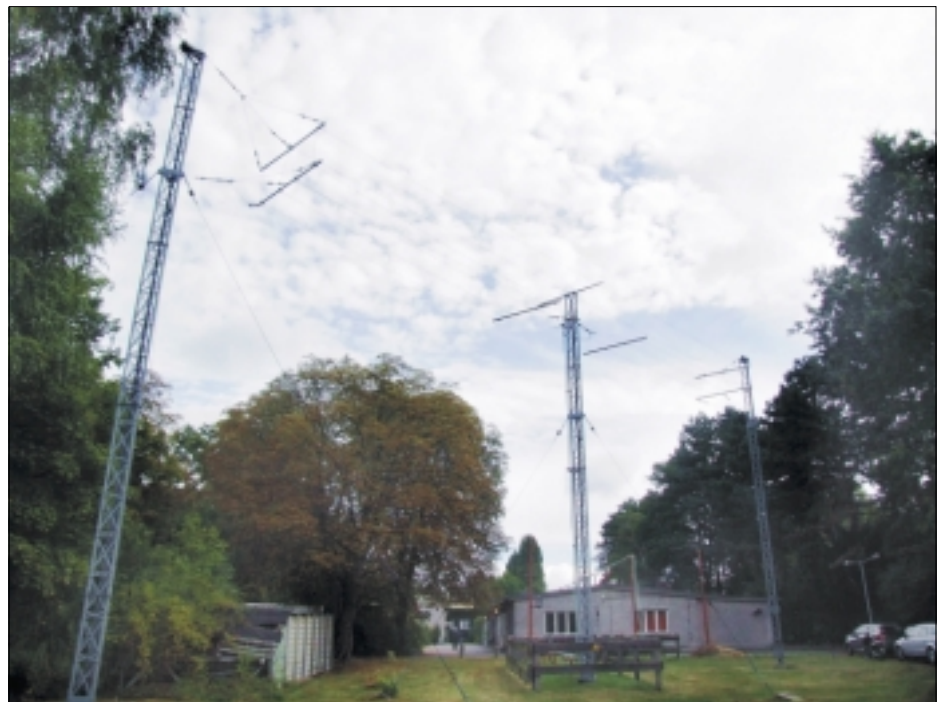
Antenne des Kurzwellensenders von 1951, dahinter die seit 1949 genutzte Senderbaracke in Berlin-Britz.
