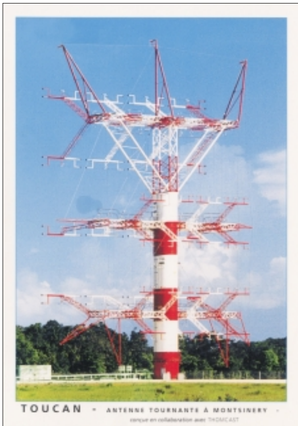
Eine der beiden Drehstandantennen in Montsinéry. Im Gegensatz zu den ansonsten identischen Anlagen in Issoudun und Nauen sind die Sender hier nicht bei den Antennen, sondern zentral im Sendergebäude installiert.
