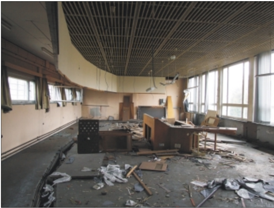
Der Schaltraum des Rundfunks der DDR bzw. das, was davon noch übrig ist.
