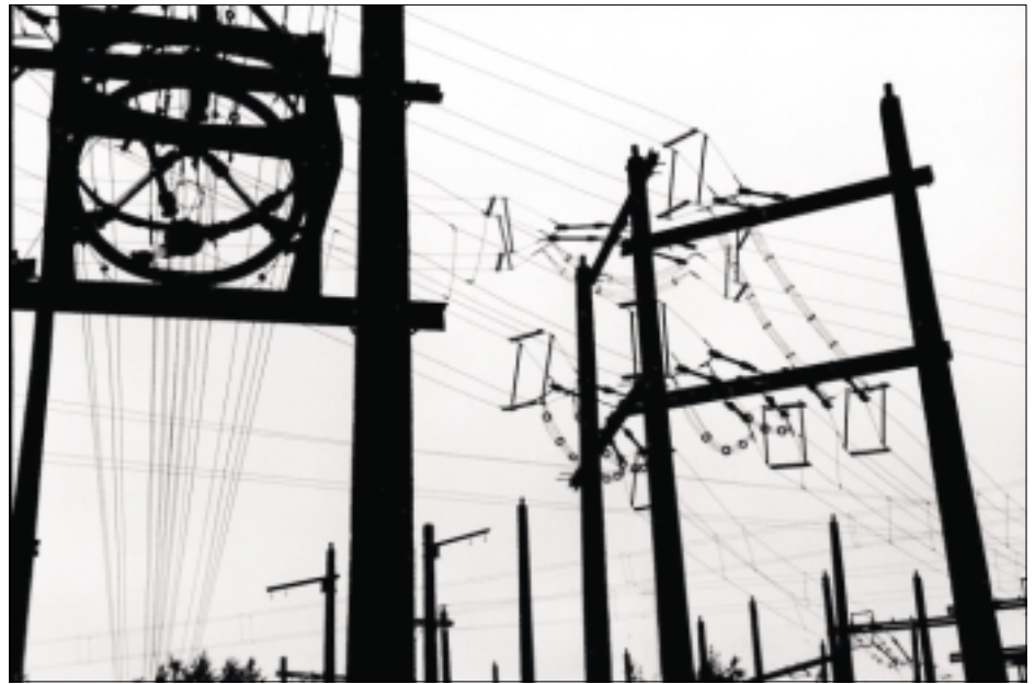
Abbildung 6: Das Fotografieren von Antennendrähten ist – wie wir alle wissen – eine extrem undankbare Aufgabe. Dieses Foto ist eines der besten, die ich je gesehen habe; der Kabelsalat beim Sendezentrum Pedaselga nahe Petrozavodsk.
