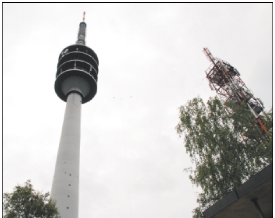
Zwischen diesen beiden Türmen ist die vertikale Drahtantenne befestigt.
