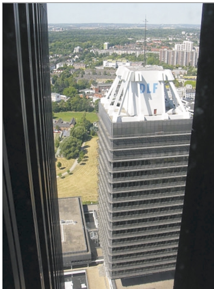
Blick auf das Funkhaus des Deutschlandfunks in Köln. Foto: Kai Ludwig.
