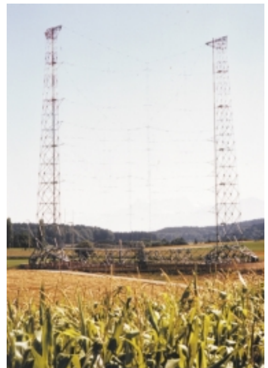
Drehstandantenne des 500-kW-Senders Sottens
