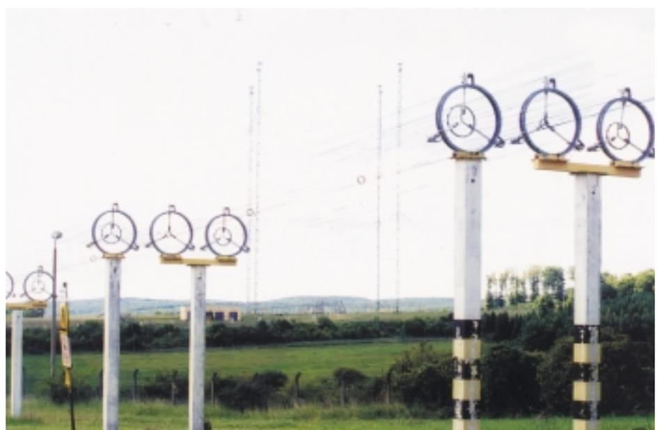
830 m lange Speiseleitung und Transformationsstück für die im Hintergrund befindliche Quadratantenne
