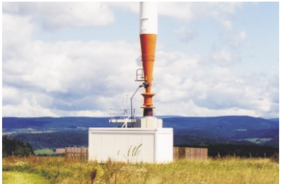
Container mit Antennenanpassung der direkt gespeisten Vertikalantenne vor dem Panorama des Thüringer Waldes
