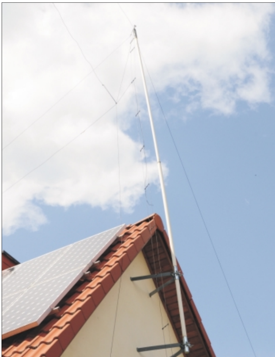
Am oberen Ende des Glasfaserstabes befindet sich der Speisepunkt der Kurzwellenantenne nach G5RV.
