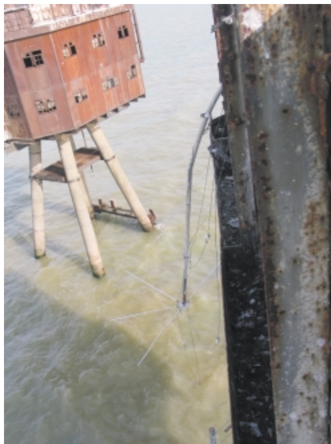
Wind und Wetter contra Technik: Winterstürme haben die Mittelwellenantenne umgerissen.
